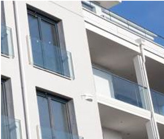
Im Stadtteil Kammgarn-Quartier in Augsburg reihen sich Industriedenkmalen an moderne Wohnbebauung. Bild: Vallox GmbH
