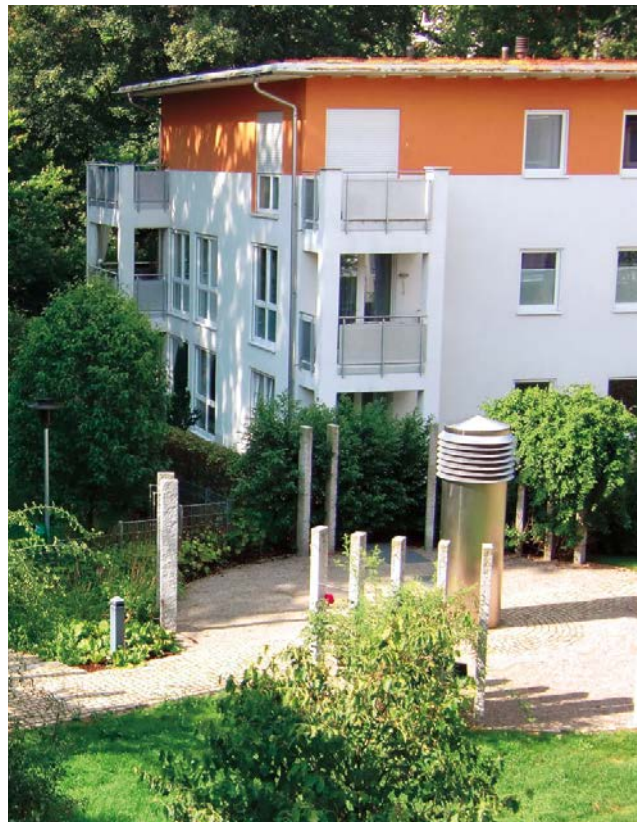
Die zentrale Außenluftansaugung für das Wohnbauobjekt Kösel-Wohnpark in Kempten/Allgäu bildet im Innenhof der Wohnanlage einen Blickfang.
